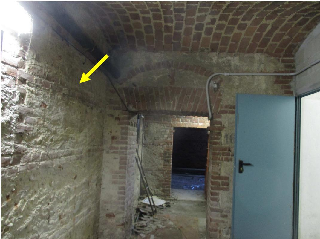
**Foto 8** : zona di demolizione muro per passaggio tubi di aerazione
