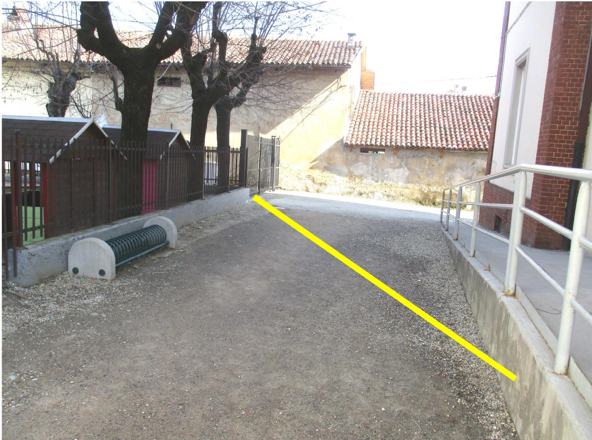
**Foto 9** : zona di scavo per posa nuova tubazione impianto idrico – antincendio
